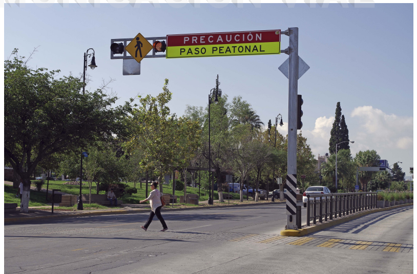
Aplicación en cruce peatonal.
